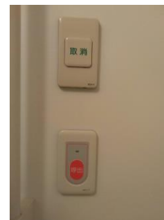
浴室緊急ボタン
